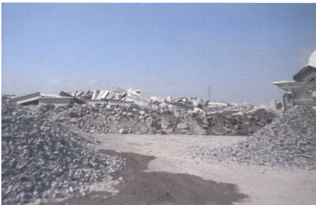
Бетонни строителни отпадъци от разрушение (на заден план) и рециклиран трошен камък от бетонни отпадъци (на преден план).
